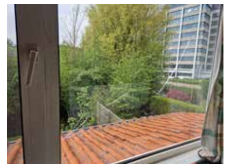
thermische breuk slaapkamerraam
