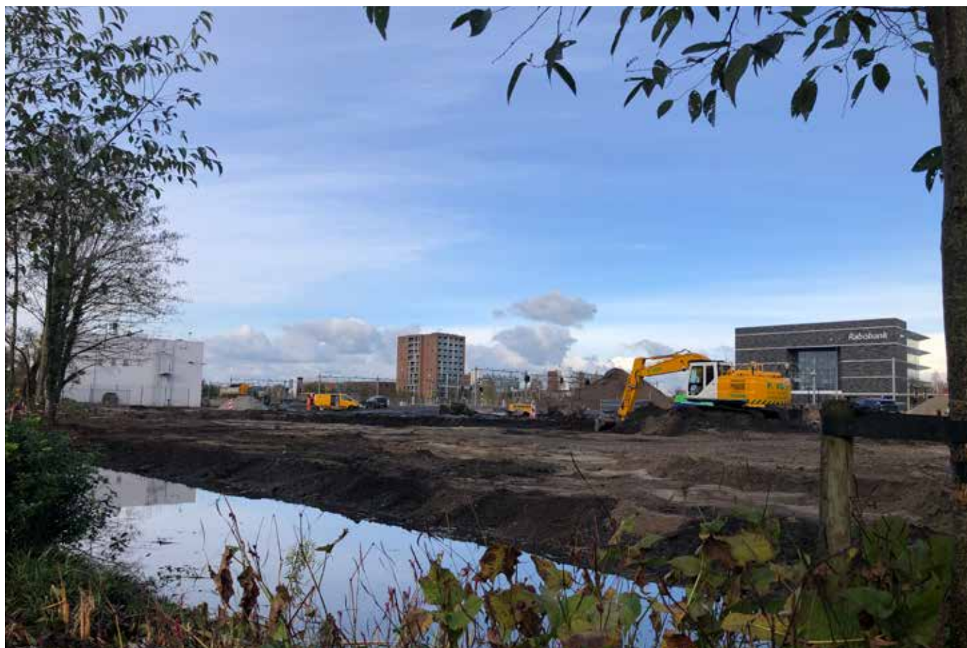
Een w i j d s uitzicht over het bouwterrein
