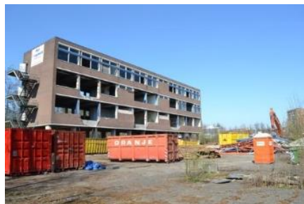
Afbraak GSG Het Segment Winterdijk
