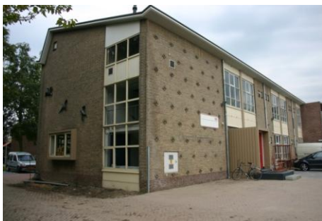
Het prachtig herstelde schoolgebouw voor cursussen in keramiek en lassen
