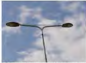
LIOR: mast rijbaan met dubbele ulthouders
