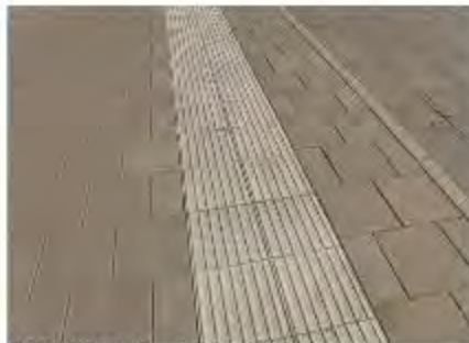
LIOR: ribbeltegel 30cm, beton
