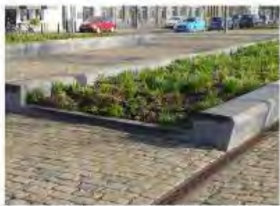
Voorbeeld plantvak stationsplein, opsluiting met hoge en lage parkbanden
