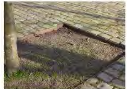
Voorbeeld stalen kantopsluiting
