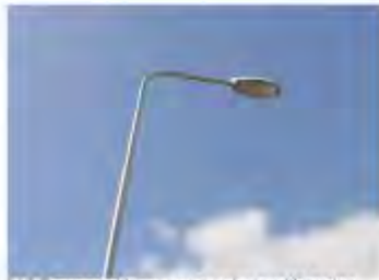
LIOR: mast rijbaan met enkele ulthouder
