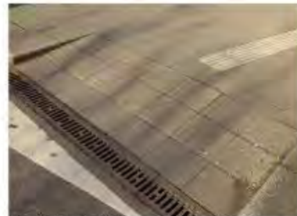
Voorbeeld noppentegel 30cm, beton
