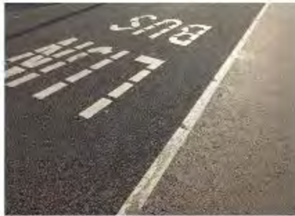
Voorbeeld asfalt bushalte
