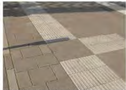
LIOR: ribbeltegel 30cm, beton
