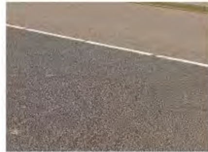
Voorbeeld asfalt bushalte, contrastwerking door structuur
