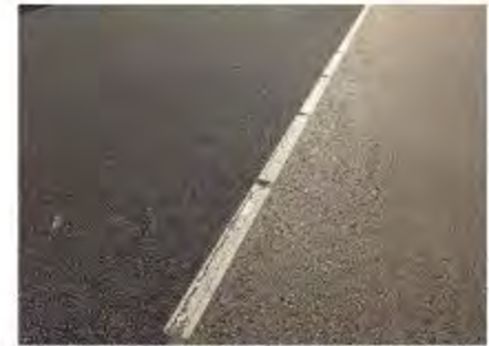
Voorbeeld asfalt bushalte, contrastwerking door structuur
