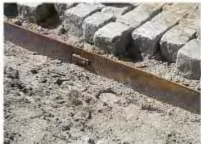
Voorbeeld stalen kantopsluiting
