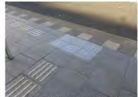
Voorbeeld markeringsvlak: klanktegels, staal
