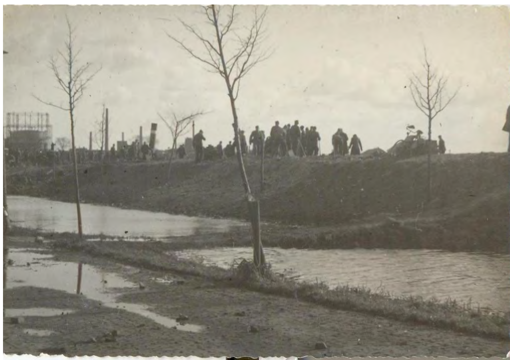
De klus is geklaard: het gat is dicht. De colonne vertrekt. Links op de foto de gastoren op het Bolwerk. Naar gelang het gasverbruik in Gouda ging de toren omhoog en omlaag.
