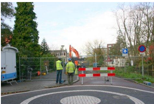
Maandagochtend 5 november begin van de rioleringswerkzaamheden op de Winterdijk
