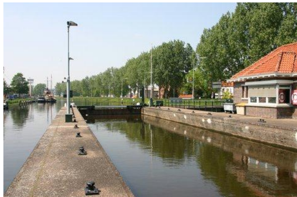
De schutsluis met de prachtige bomengalerij langs de Nieuwe Gouwe O.Z.
