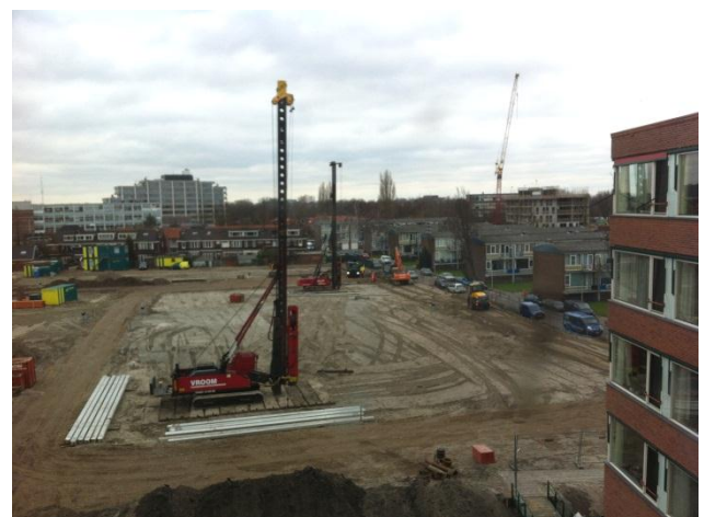
zicht op bouwterrein vanaf Gouwestein
