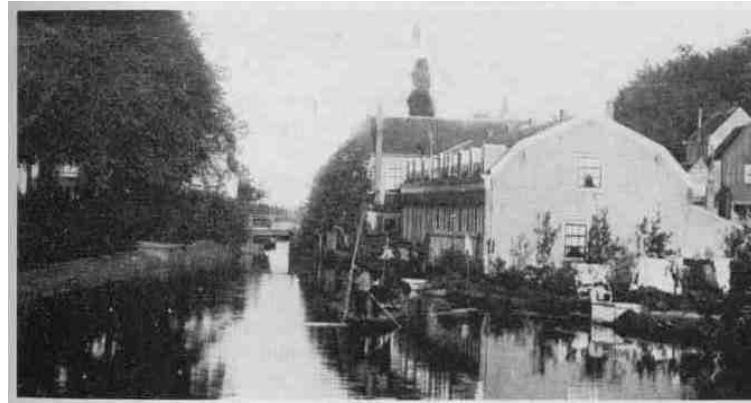
Ca 1900 huizen langs Jan Verzwollewetering, die later gebombardeerd en gesloopt zijn.
