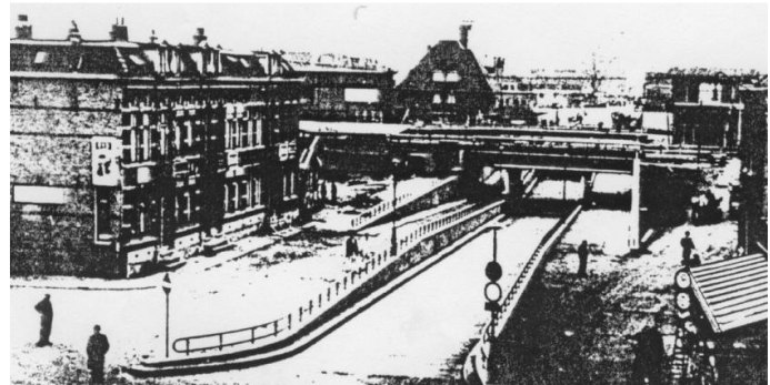
De nieuwe spoortunnel
