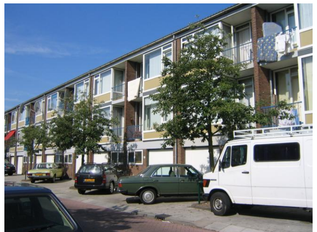
achterzijde woningen Roos van Dekemastraat
