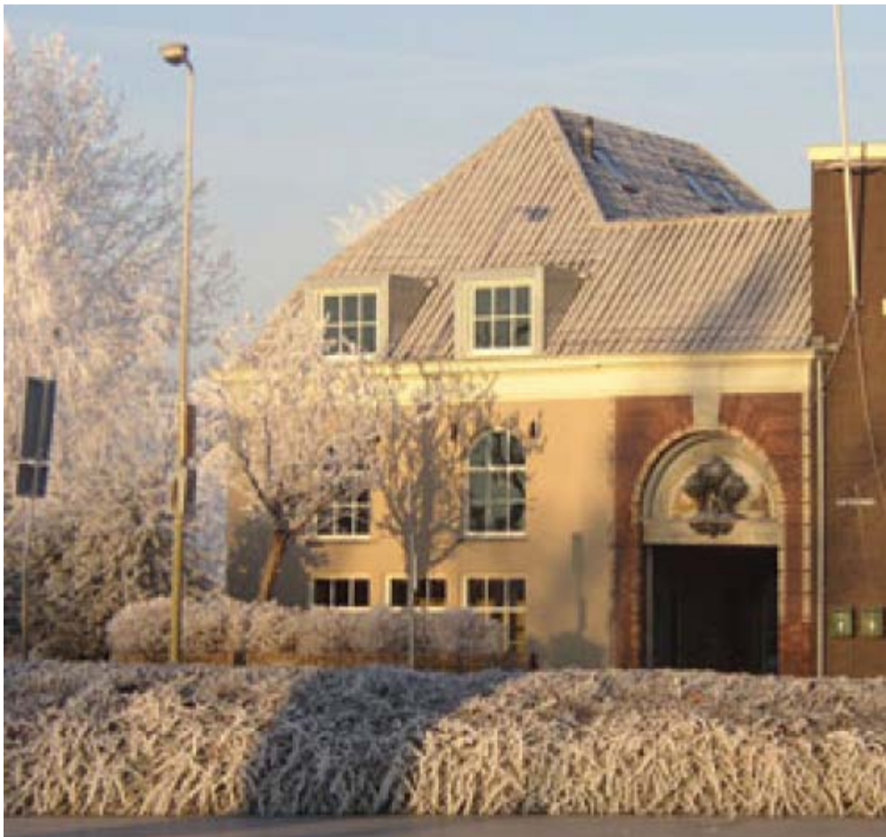
Na de restauratie
