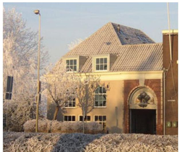
Na de restauratie
