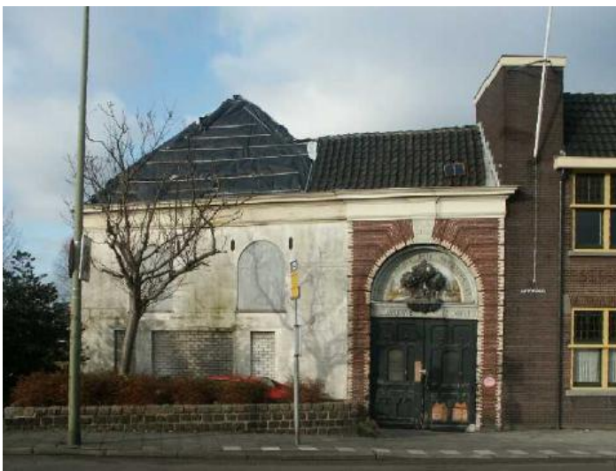
Voor de restauratie
