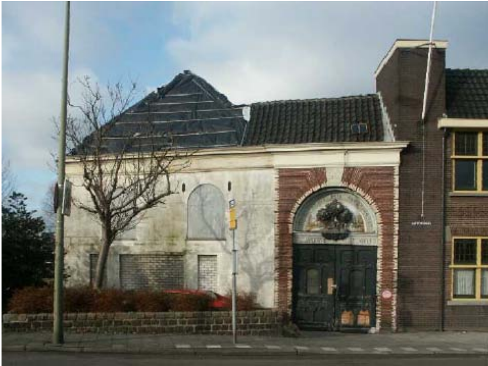
Voor de restauratie
