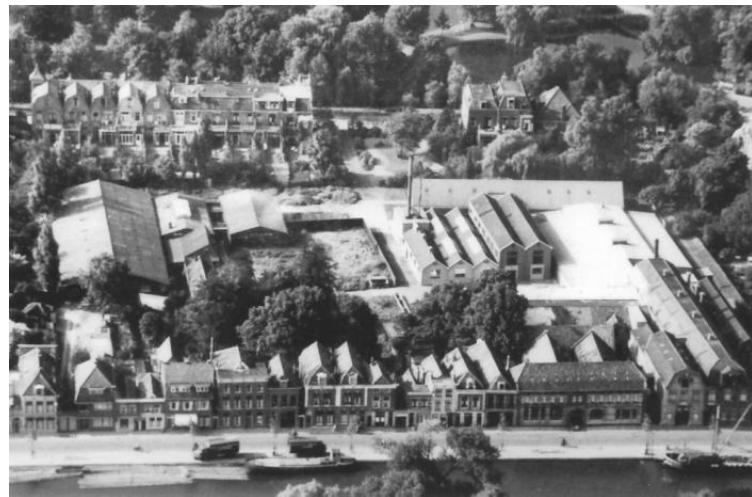
Oude luchtfoto van het terrein (onder de Kattensingel, boven van Beverninghlaan)
