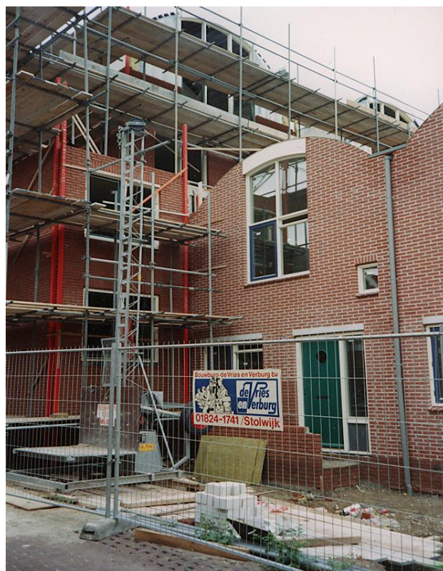
Het huis van Theo in aanbouw
