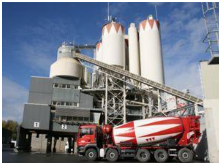
Goudse Betonmortel Centrale
