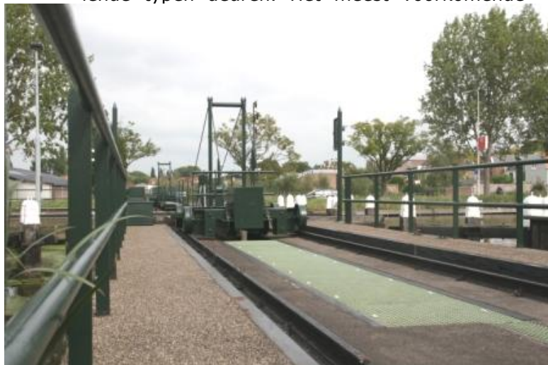
De rails van de roldeur
