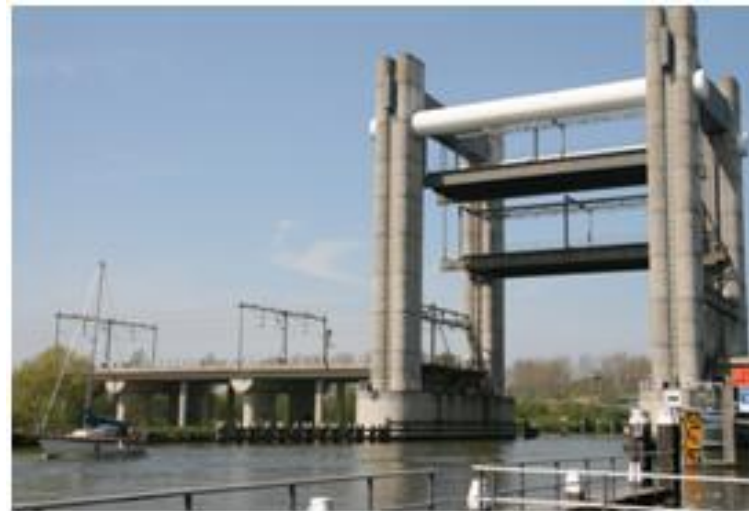
De hefbrug. Hierop is goed te zien dat de twee delen afzonderlijk omhoog gaan
